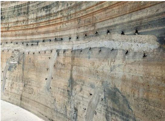
Das Injektionsharz IR PUR 2K WW von Remmers dichtet Abwasser- sowie von Jauche-, Gülle- und Silagesickersaftanlagen (JGS) sicher ab.
